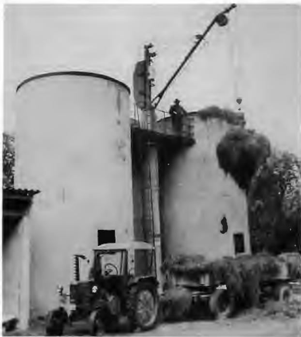
Bild 2: Hochsilos mit Drehkran und Selbstgreifer (Foto: SCHIFFER).
